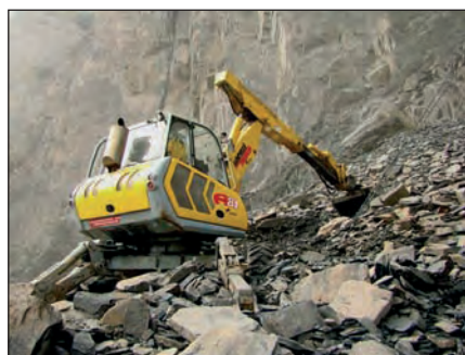
Figure 9 - Travail sur l'éboulis à la pelle araignée.
