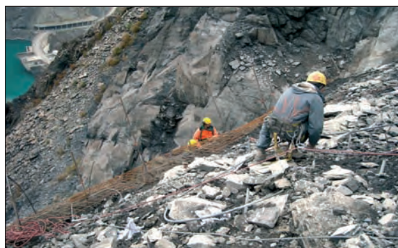
Figure 10 - Des conditions de travail particulières sur la tête du tunnel (injection d'étanchéité).
