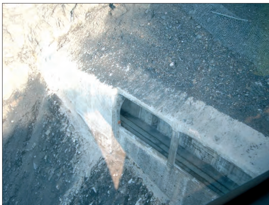
Figure 15 - Confortement de l'ouvrage terminé, l'éboulis a repris son profil naturel.
