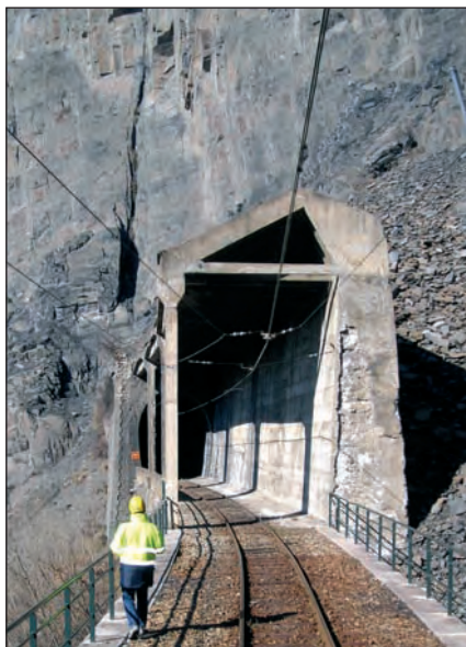
Figure 6 - La galerie de protection de 1921 et au fond le tunnel.
