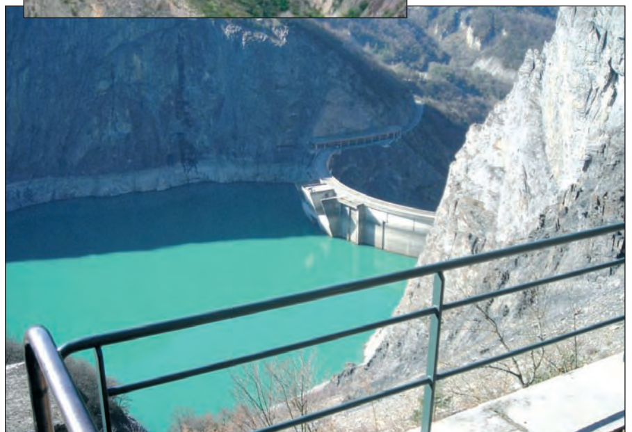
Figure 5 - Vue plongeante sur le barrage de Monteynard depuis la plateforme ferroviaire.
