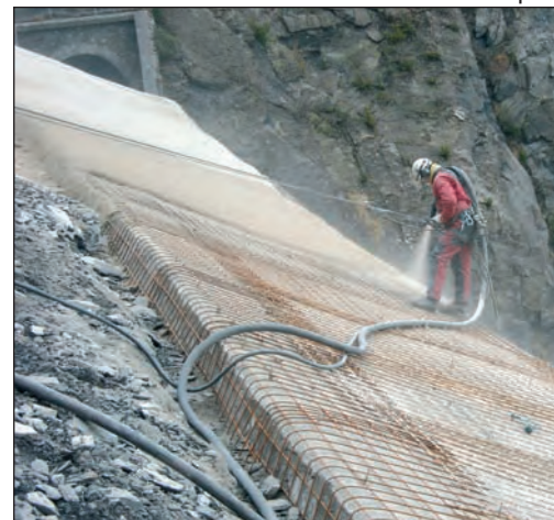
Figure 14 - Application de la protection d'étanchéité sur la couverture de la galerie.
