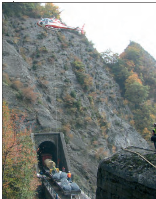
Figure 8 - Approvisionnement du chantier par train, mise en place par hélicoptère.
