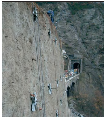
Figure 13 - Confortement du piédroit aval.
